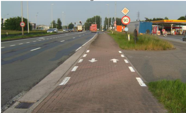
Figuur 14: voorbeeld van hoe wegmarkeringen de aandacht kunnen vestigen op de aanwezigheid van een tweerichtingsfietspad
