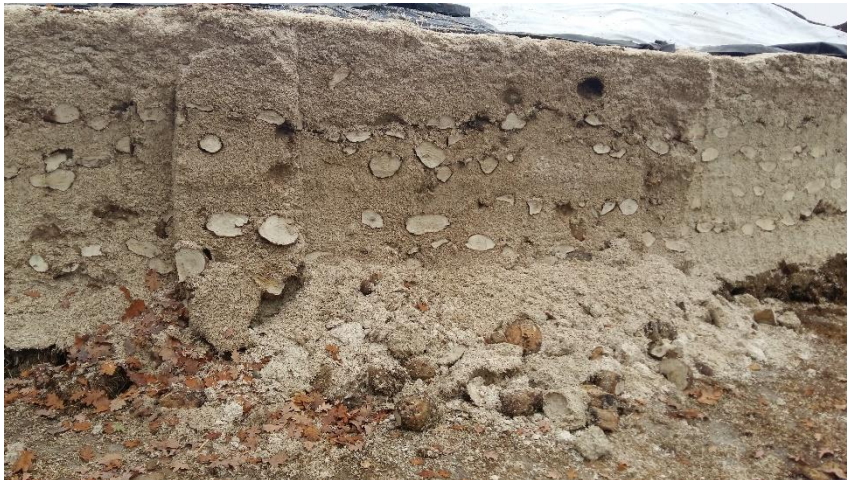
Figuur 3-6: Mengkuil op bedrijf A
