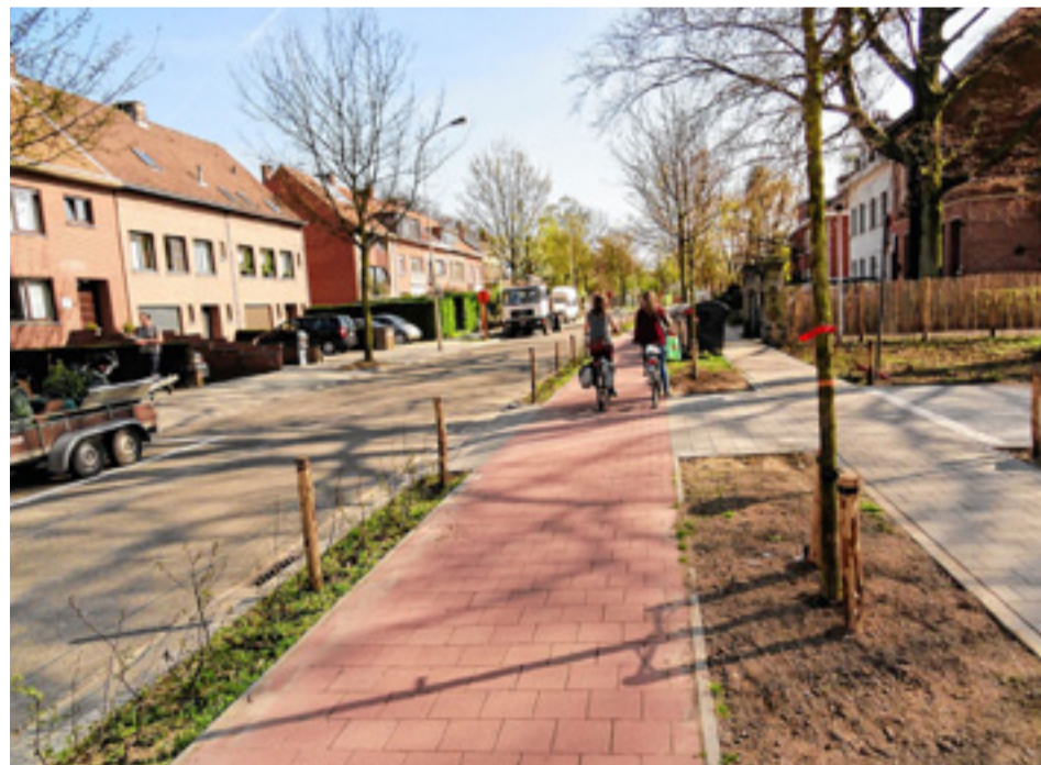
Nieuw fietspad in Kontichstraat Edegem. FOTO PROVANT
