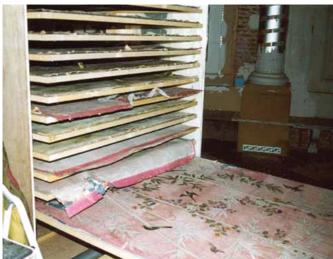
De behangselbanen werden één voor één horizontaal gestapeld in de stapeltoren
