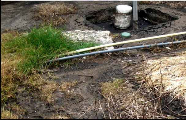
Ondergrondse mazouttank met mest
